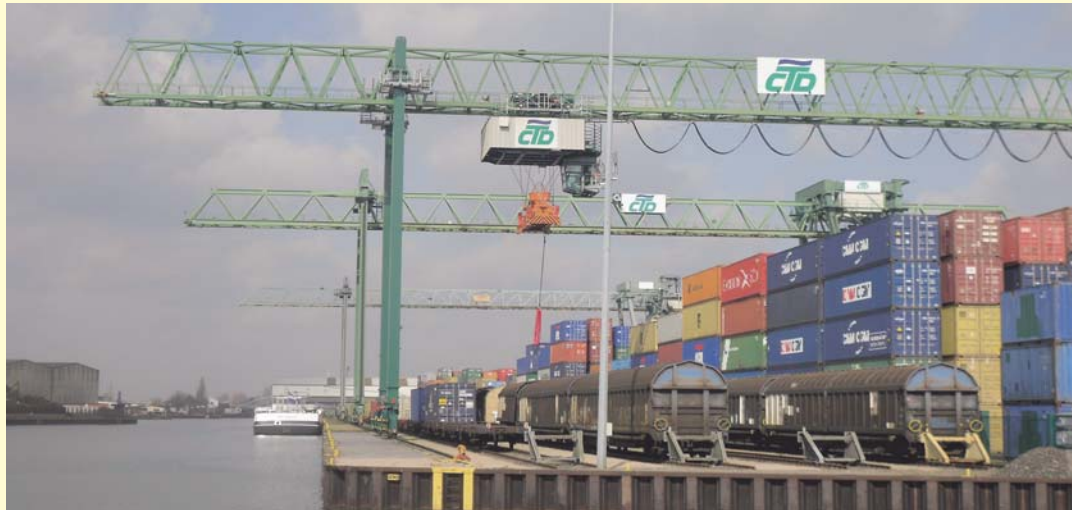
Seit Januar 2009 arbeiten im CTD drei Containerbrücken
